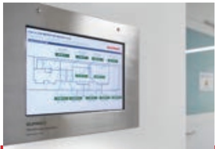
生產車間&無塵室
